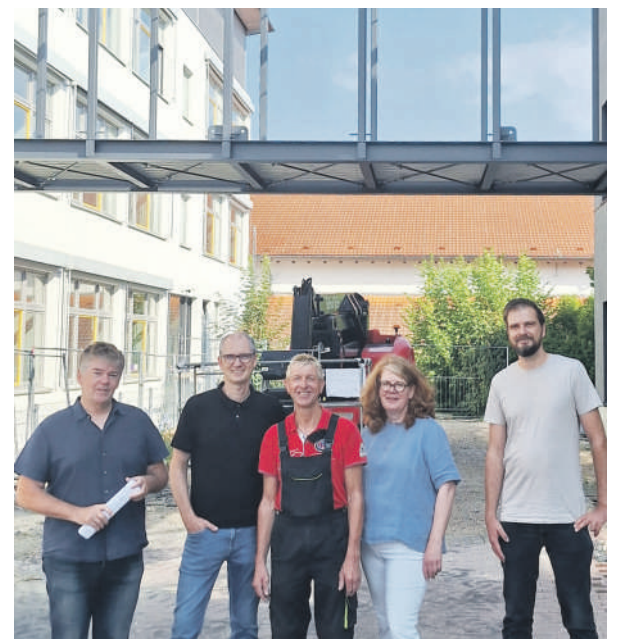
Begutachten den Baufortschritt an der Helpuper Grundschule: (von links) Manfred Stenzel (Bauleiter SBP Architekten), Marc Plaßmann (Fachbereichsleiter Bauen und Umwelt/Stadt Oerlinghausen), Martin Bötdeker (Hausmeister Grundschule Helpup), Ulrike Petersen (Direktorin Grundschule Helpup) sowie Marc Balsmeier (Bauherrenvertretung für die Stadt).
