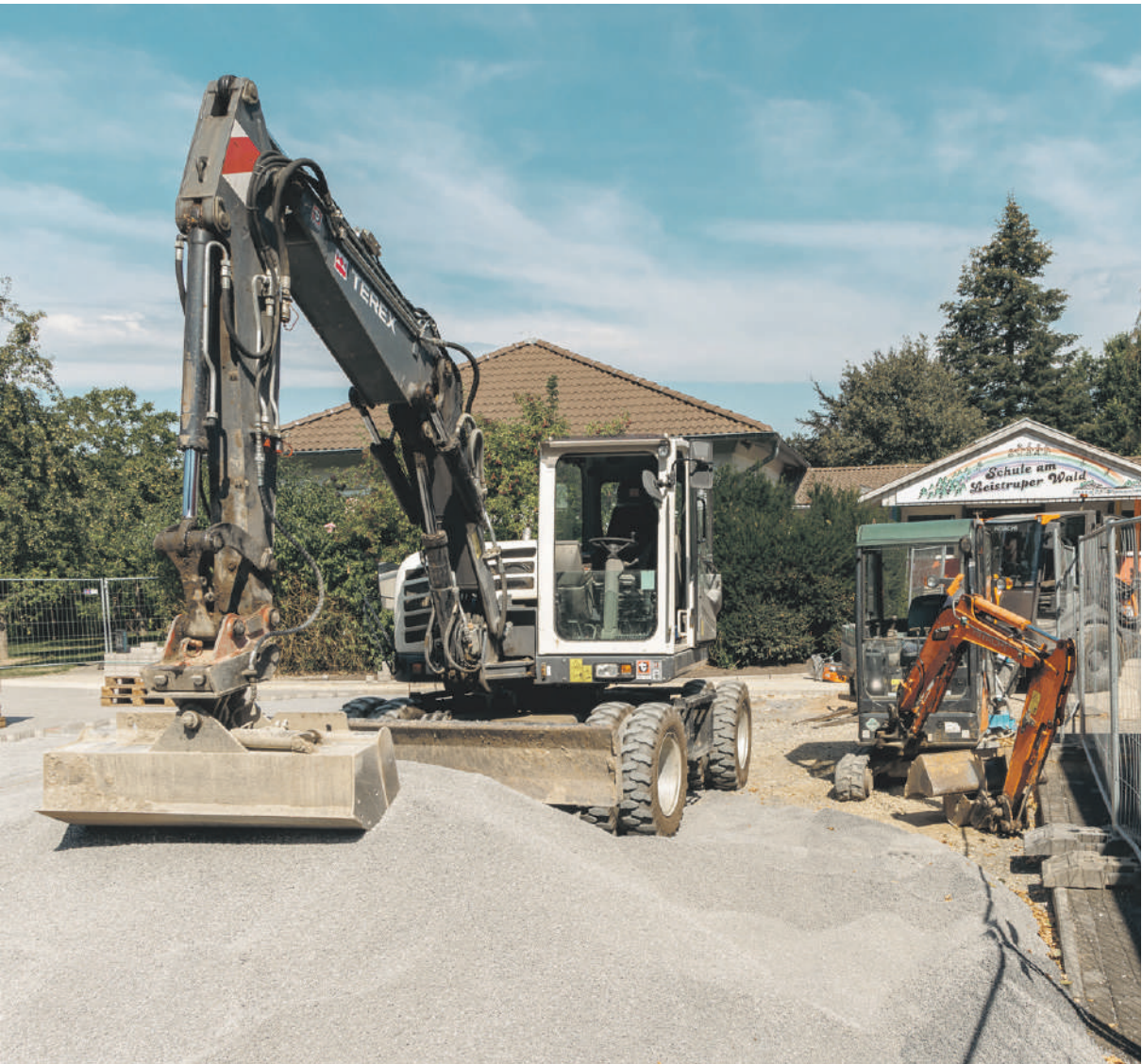
An der Grundschule am Leistruper Wald in Diestelbruch ist der Bagger im Einsatz.
