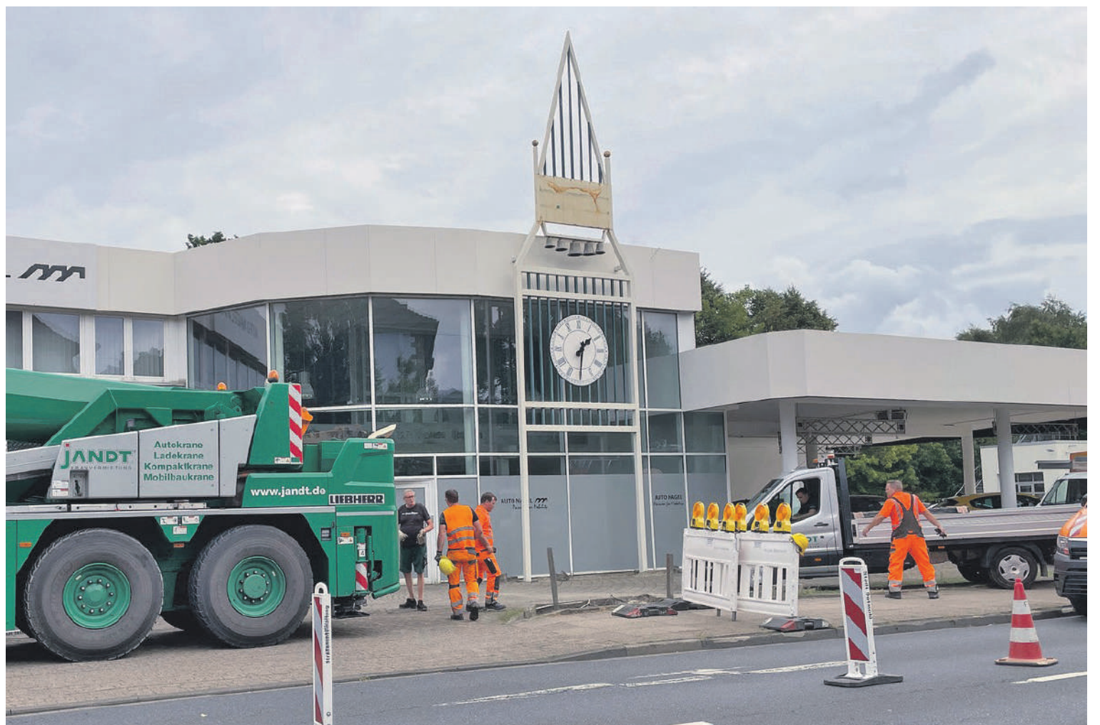
Der Abbau-Trupp bei der Arbeit: Nach Jahrzehnten in Bielefeld soll der „Big Ben“-Turm künftig in Detmold stehen.
